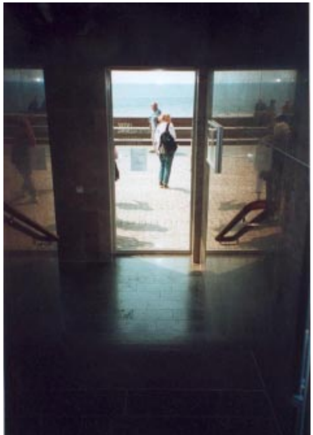
• Glänsande kalksten i motljus, trappsteg blir osynliga och fönsterglas kan tolkas som öppning. Fast dörren ligger runt hörn till vänster. (33-34)
