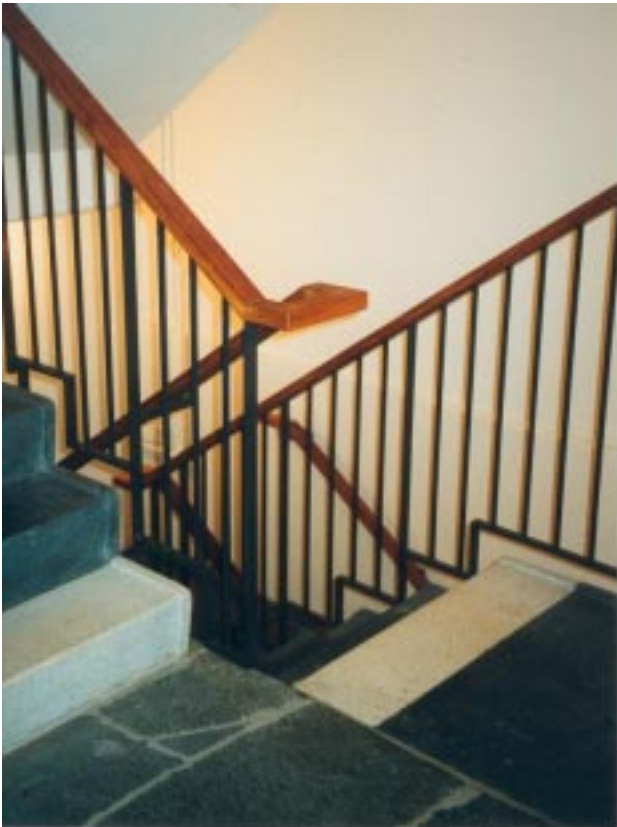
• Bara ett trapphus har både kontrastmarkerade första och sista steg i trappor och förlängda ledstänger. (27)
