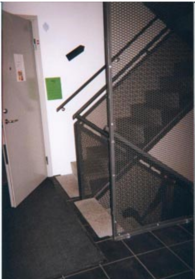
• Här finns kontrastmarkering, men den är missvisande. Kontrasten ska ligga mellan vilplan och första steg upp, se bild ovan. (21-24)
