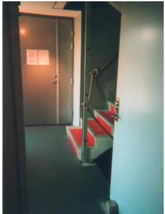
• Här finns kontrastmarkering mellan vilplan och steg upp, men ingen markering på vilplan av steg ner, som på bild till vänster. (35)
