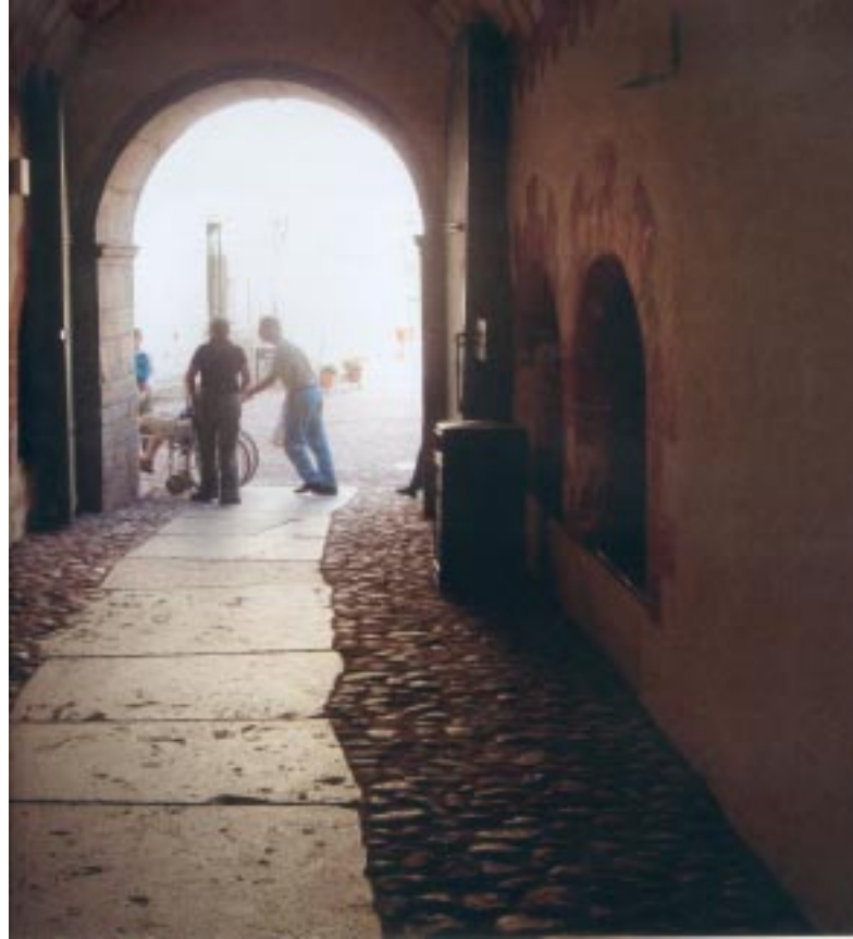
Brett ledstråk med släta kalkstenshällar kantade av kullersten. Ett tydligt ledstråk i gammal miljö
